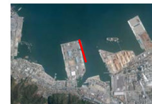
岩国港新港地区 (山口県岩国市)
