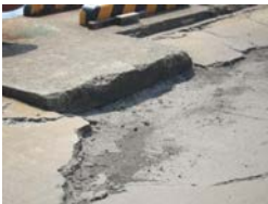
老朽化しエプロンに亀裂や段差が発生 呉港川原石地区岸壁(広島県呉市)
