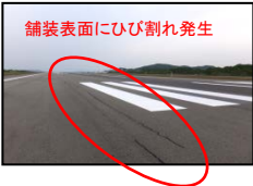
舗装表面に経年劣化によるひび割れが発生 広島空港(広島県三原市)
