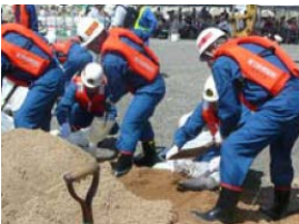
土のう積みの実施(岡山県岡山市)
