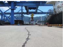
老朽化しエプロンに亀裂や段差が発生 呉港川原石地区岸壁(広島県呉市)
