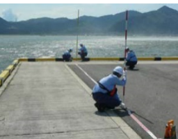
TEC-FORCEによる被災状況調査
