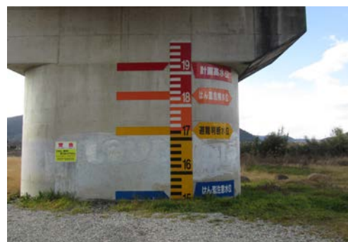
水位表示の設置状況
