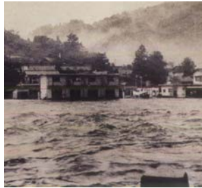
昭和47年7月(梅雨前線) 洪水の状況 (美咲町(旧柵原町))
