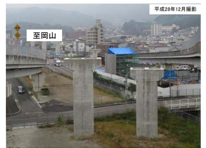
写真③海田西IC 橋梁下部工
