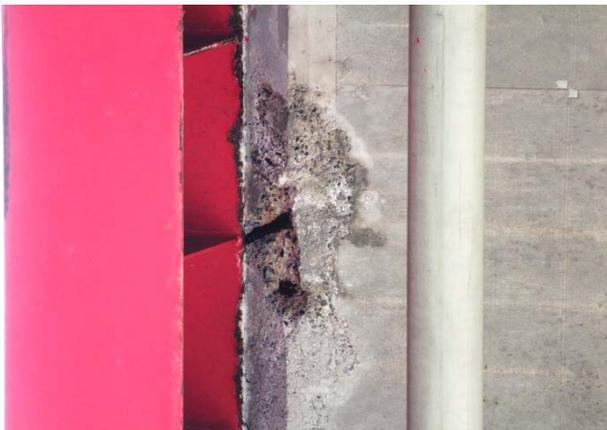
損傷状況(床版下面の鉄筋露出)
