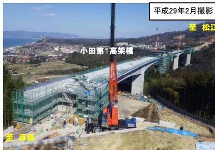
写真②小田第1高架橋の橋脚工事の様子
