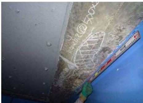
損傷状況(部材の塗装劣化)
