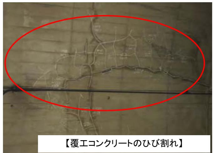
【覆工コンクリートのひび割れ】
