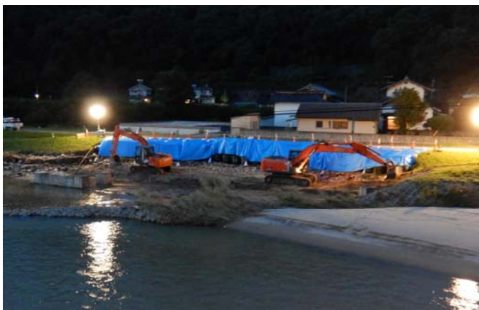
堤防盛土状況
