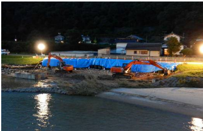
堤防盛土状況
