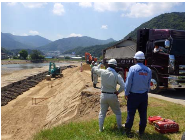
堤防盛土状況
