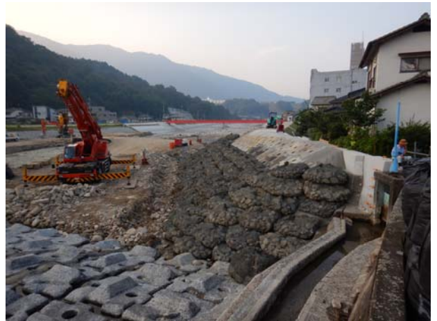
緊急対策工事完成時
