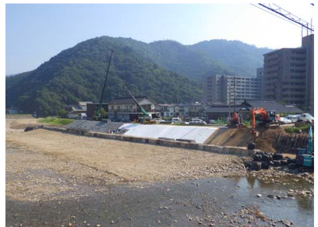
護岸ブロック据付状況
