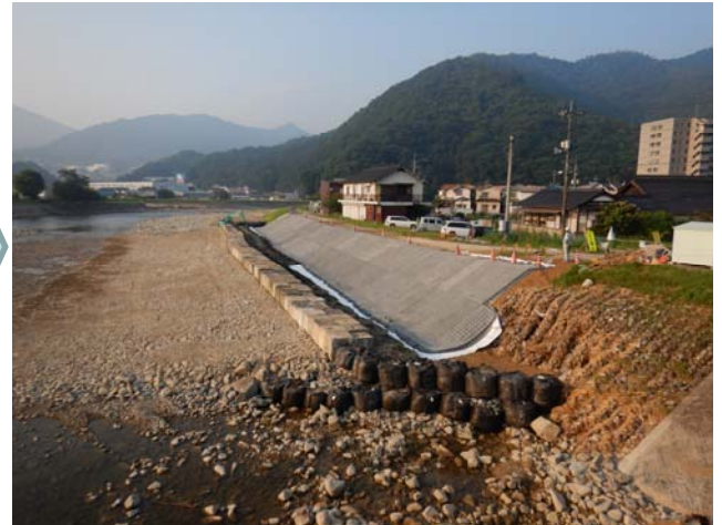
緊急対策工事完成時
