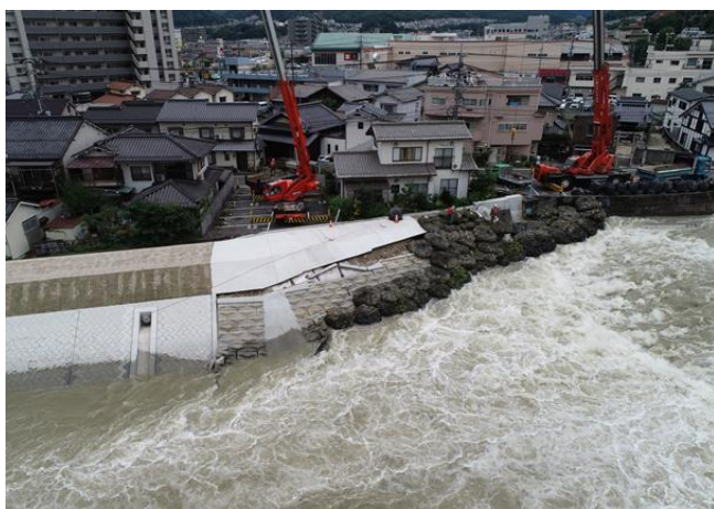
侵食拡大防止緊急対策状況
