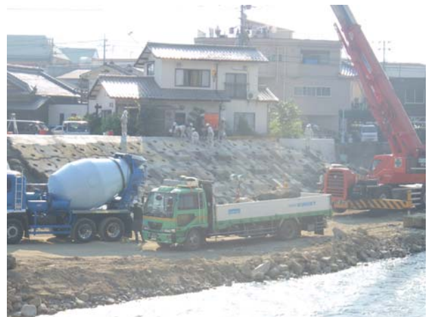
護岸ブロック据付状況
