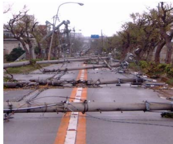
<電柱の倒壊による道路閉塞の事例>
