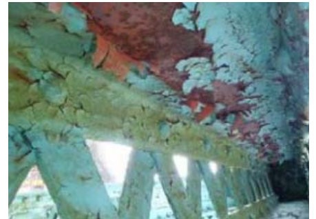
写真③ 下弦材の腐食状況
