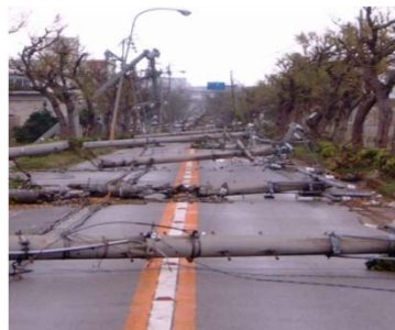
＜電柱の倒壊による道路閉塞の事例＞
