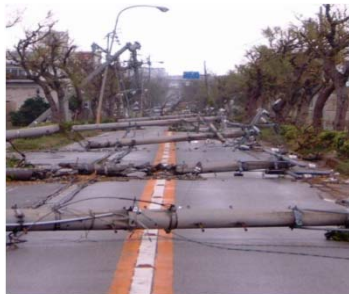
＜電柱の倒壊による道路閉塞の事例＞
