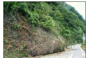
写真② 国道262号道路路面崩壊状況
