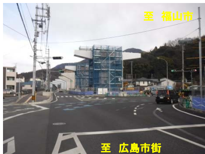
写真③海田高架橋施工状況
