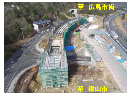
写真①八本松IC施工状況
