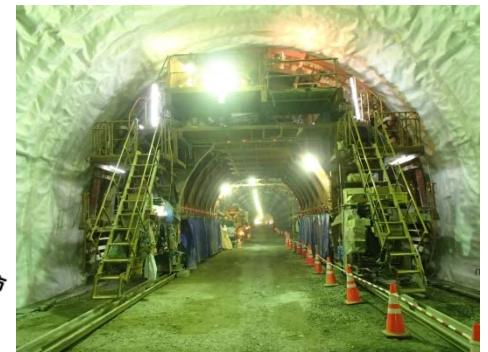
【写真②】覆エコンクリートの施工状況
