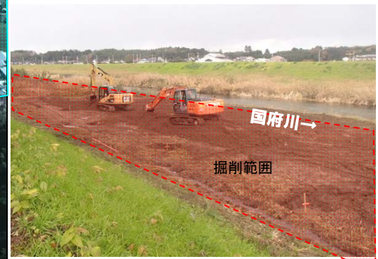
＜掘削状況写真＞
