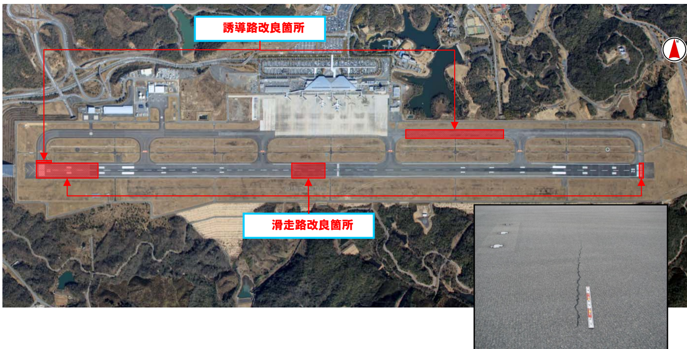
舗装表面の経年劣化によるひび割れの発生
