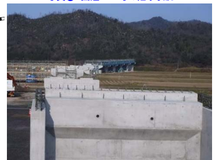
写真② 浦富地区施工状況
