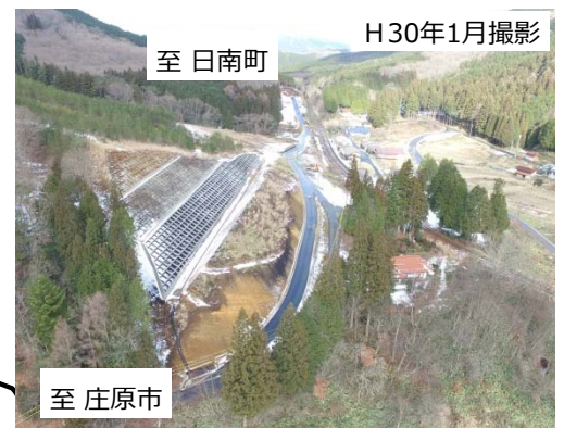
【写真①】高尾地区の施工状況
