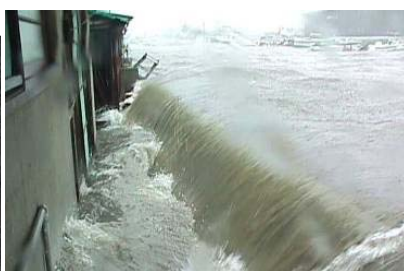
高潮により堤防を越水する様子(平成11年台風18号)
