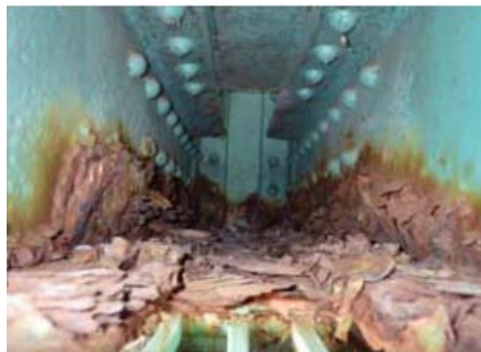
写真② 主桁の腐食状況
