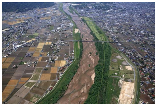
天井川で有名な斐伊川下流
