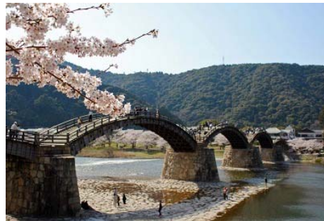
五連の木造アーチの錦帯橋
