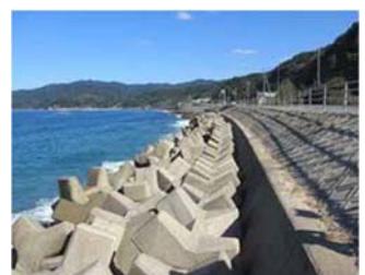
対策事例(消波ブロック設置)
