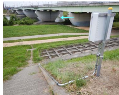
危機管理型水位計設置状況
