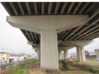
補強が必要な橋脚
