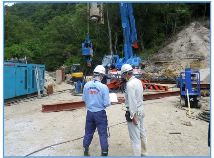
仮橋施工状況 ②
