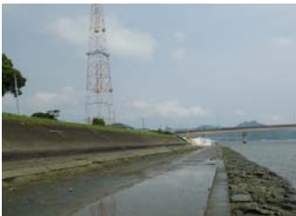
高潮対策が必要な箇所
