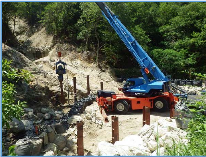
仮橋施工状況 ①
