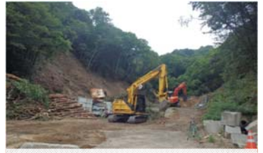
樹木伐採 施工状況
