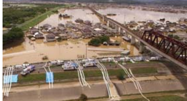
【H30.7月豪雨】 (岡山県倉敷市真備町)
