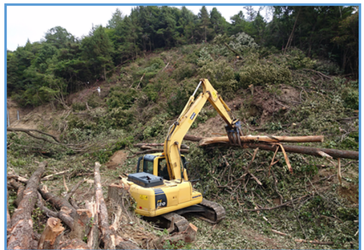
砂防堰堤の樹木伐採状況 ②
