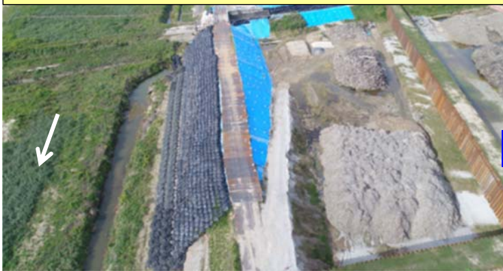
平成30年10月30日 本復旧工事に着手
