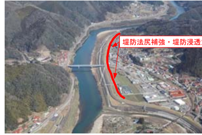
堤防強化が必要な箇所
