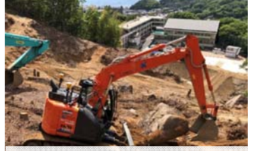
本体掘削 施工状況
