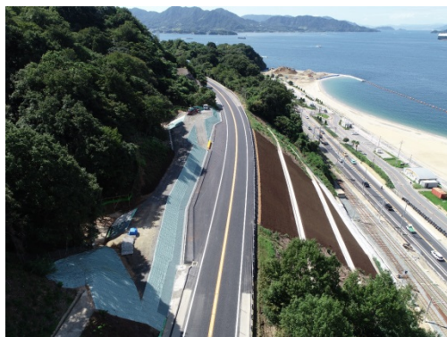
広島県道路、国道31号復旧状況(広島県安芸郡坂町)
