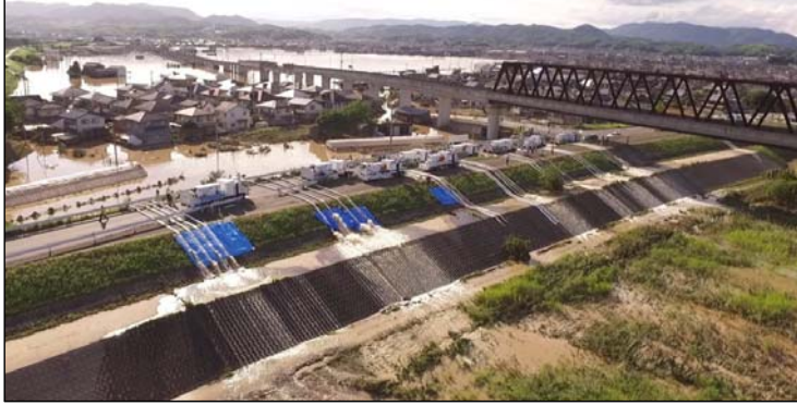
(平成30年7月8日撮影 岡山県倉敷市真備町における緊急排水)
