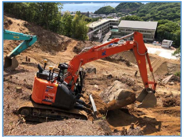
砂防堰堤の本体掘削状況 ②
