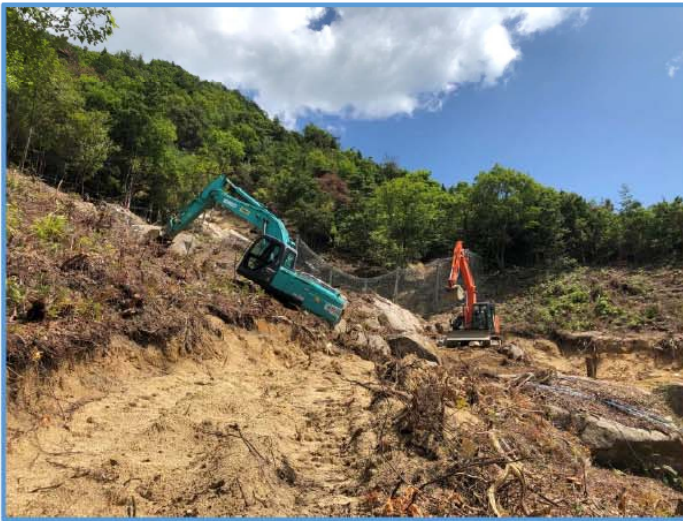
砂防堰堤の本体掘削状況 ①
