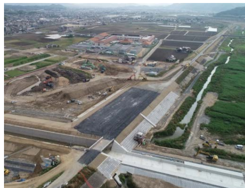
小田川堤防復旧状況(岡山県倉敷市真備町)
