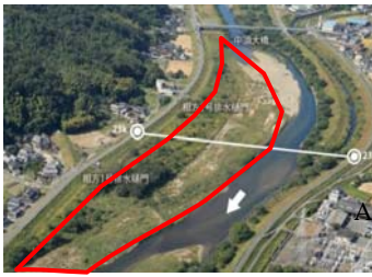
河道掘削・樹木伐採が必要な箇所
