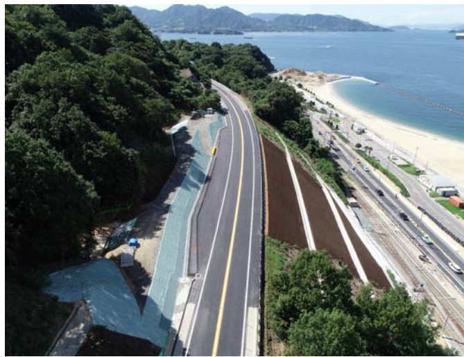
広島県道路、国道31号復旧状況(広島県安芸郡坂町)
