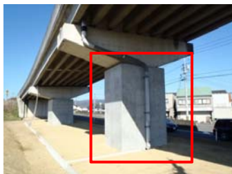
対策事例(橋脚の補強)
