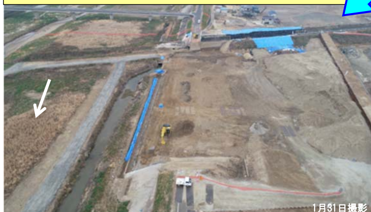
荒締切堤防 (仮設堤防) の撤去完了
