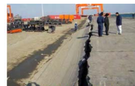
岸壁の耐震化
