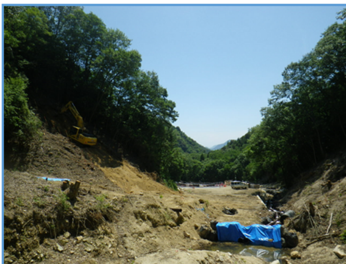
砂防堰堤の本体掘削状況 ①
