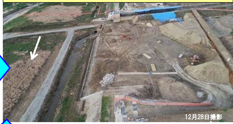
荒締切堤防 (仮設堤防) の撤去作業中
