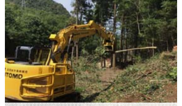
樹木伐採 施工状況
