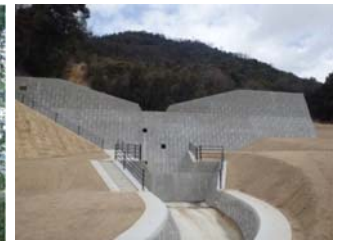
対策事例(砂防堰堤)
