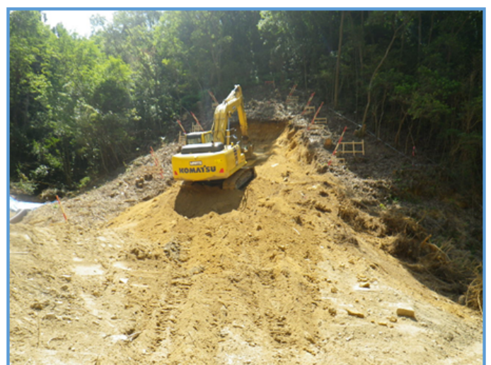
砂防堰堤の本体掘削状況 ②
