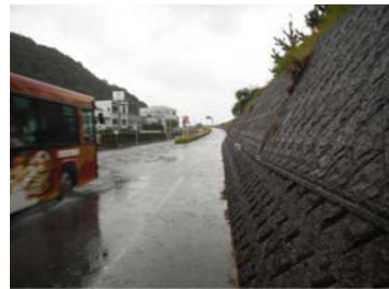
道路の冠水状況
