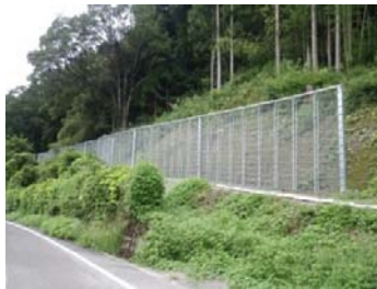
対策事例(法面対策)
