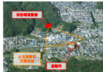
砂防堰堤整備が必要な箇所
