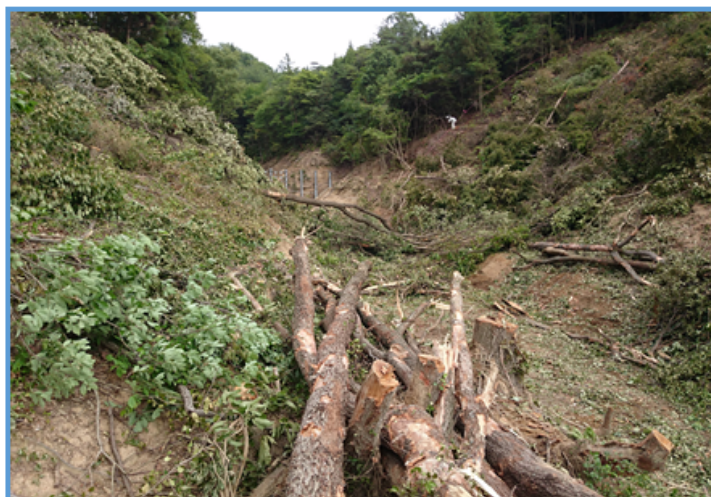
砂防堰堤の樹木伐採状況 ①
