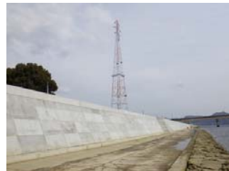
対策事例(高潮堤防整備)
