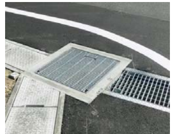
対策事例(排水施設の設置)
