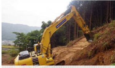
本体掘削 施工状況
