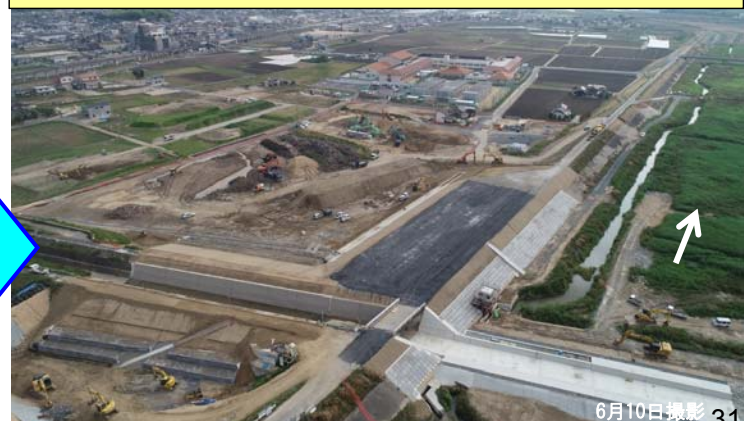
本堤防の復旧完了
