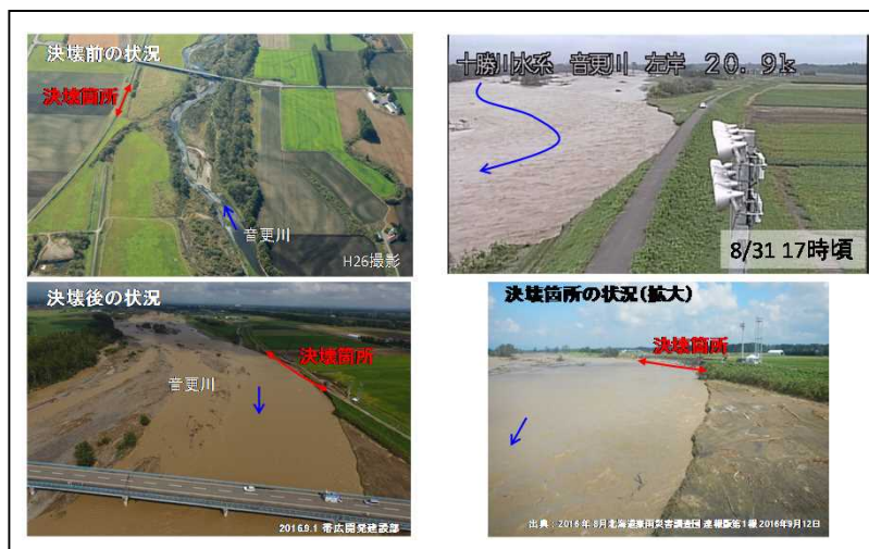
河岸侵食の事例
