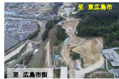
写真③瀬野東IC施工状況
