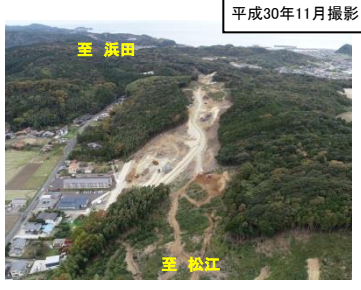
写真③ 長久地区の道路改良工事の様子
