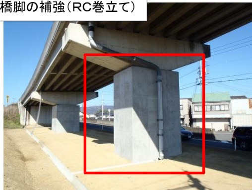
橋脚の補強(RC巻立て)
