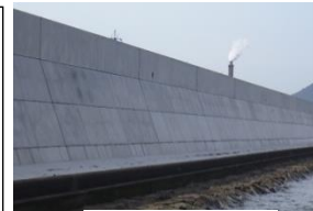
完成した高潮堤防
