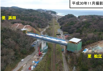
写真② 静間跨線橋の上部工事の様子
