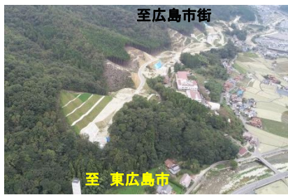
②上瀬野地区施工状況
