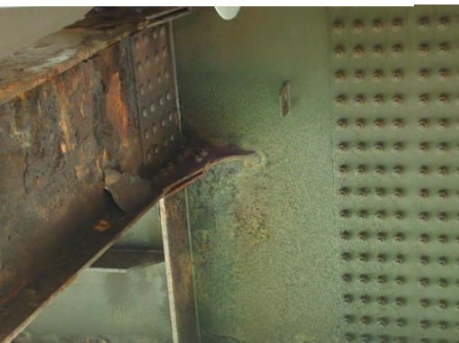
鋼桁の腐食
