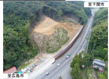
写真①周南市戸田地区(施工状況)
