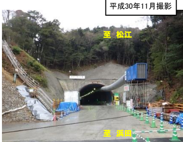
写真① 五十猛トンネル工事の様子
