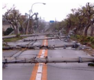
<電柱の倒壊による道路閉塞の事例>
