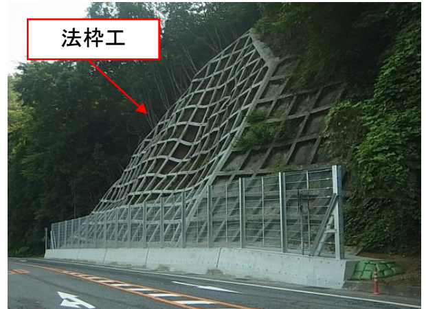
法面对策事例
