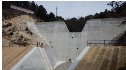
緑井・八木地区で完成した砂防堰堤(H29.3完成)
