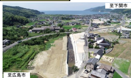
写真②防府市富海地区(施工状況)
