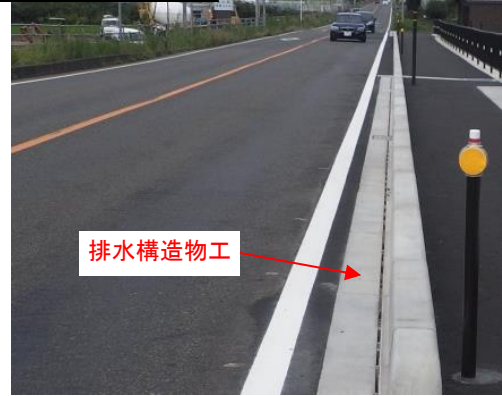
冠水対策事例
