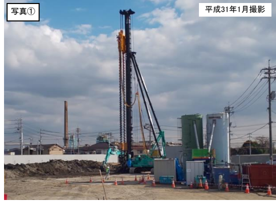
【写真①】大福地区の施工状況(地盤改良)
