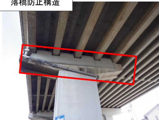
落橋防止構造
