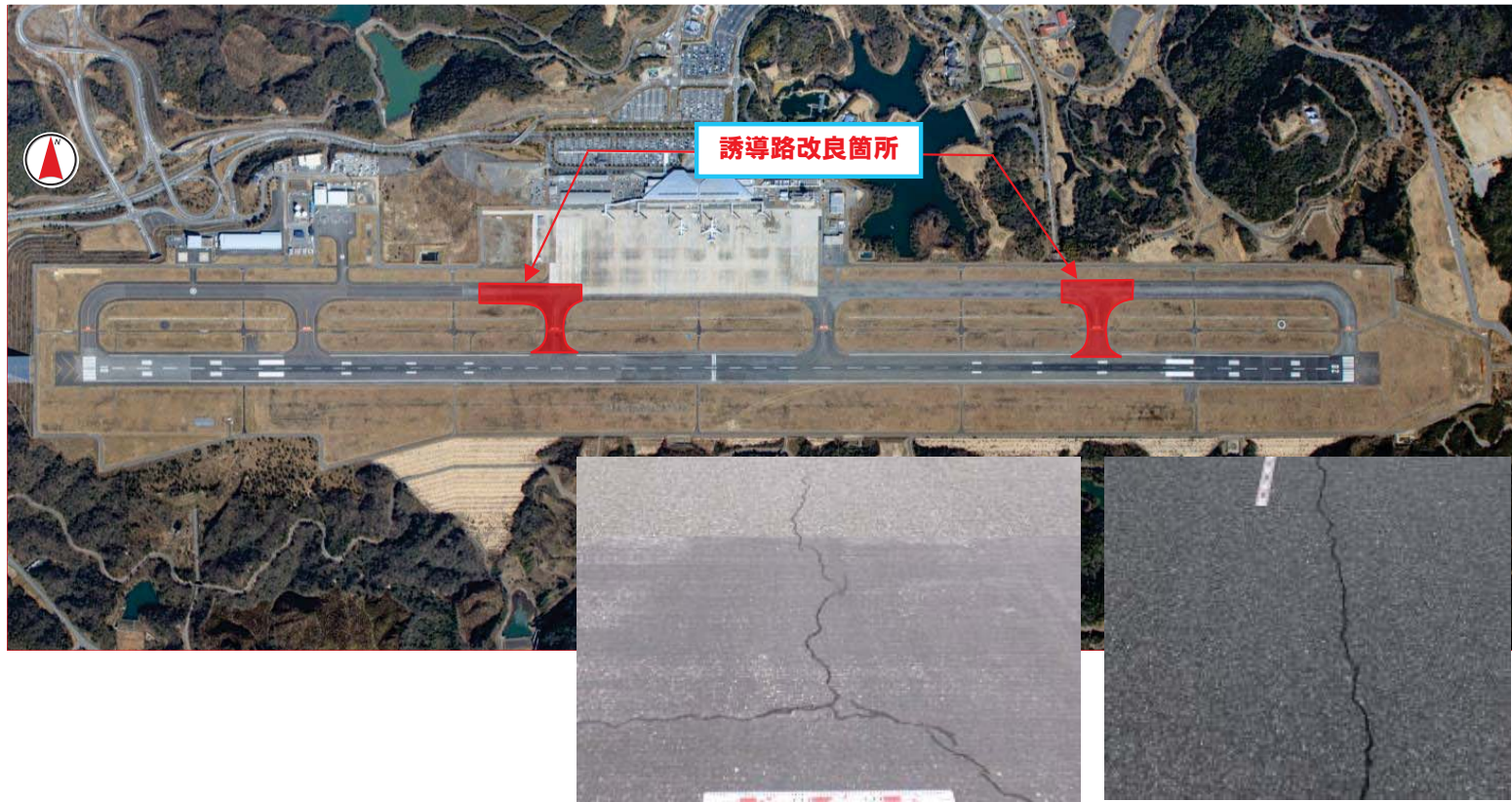
誘導路の舗装表面に発生した経年劣化によるひび割れ
