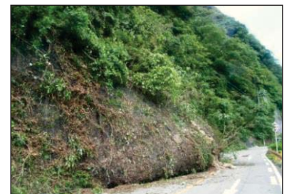
写真② 国道262号道路路面崩壊状況 (H25.10月時点)
