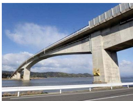
写真① 中海大橋 全景
