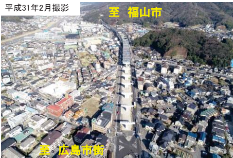
写真③海田高架橋施工状況
