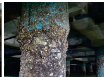
杭の劣化状況
