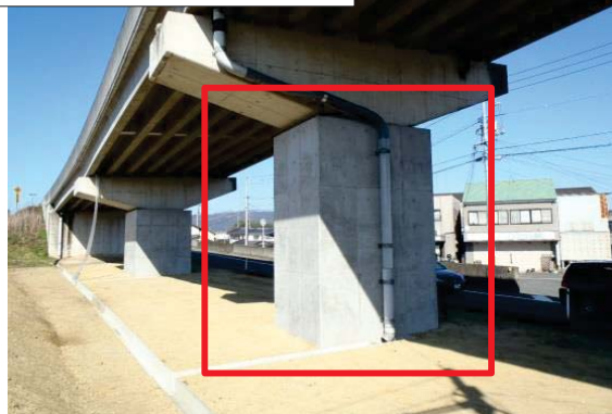
橋脚の補強(RC巻立て)
