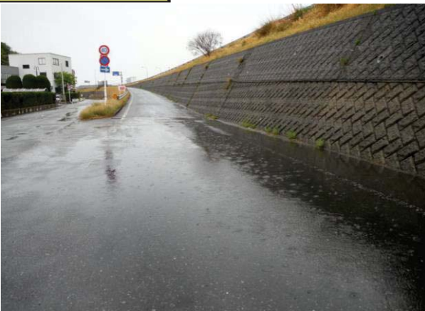
豪雨発生時状況
