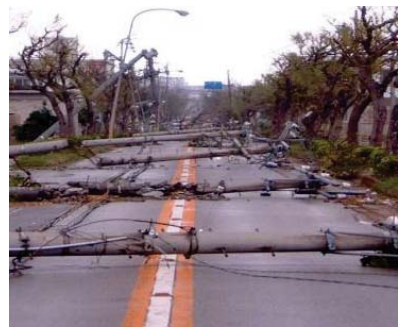
<電柱の倒壊による道路閉塞の事例>
