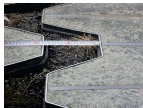
写真③ 伸縮装置の異常遊間
