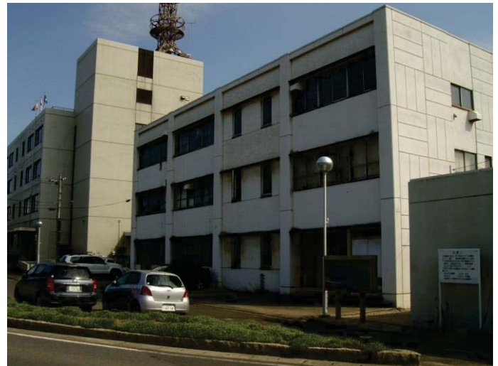
水島港湾合同庁舎1号館(現況)
