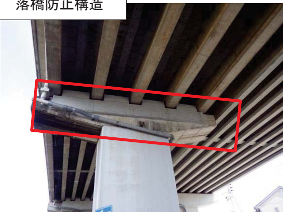
落橋防止構造
