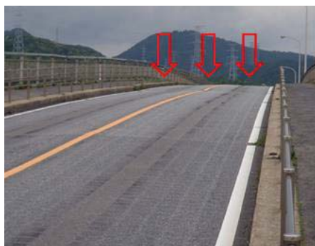
写真② 主桁の垂れ下がりが
