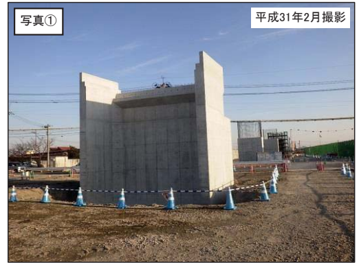
【写真①】大福地区の施工状況（橋梁下部工）
