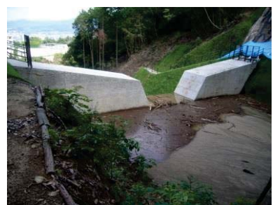
土石流の捕捉状況
