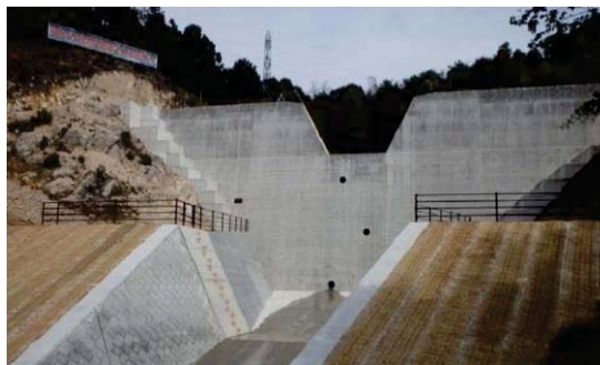
緑井・八木地区で完成した砂防堰堤 (H29.3完成)
