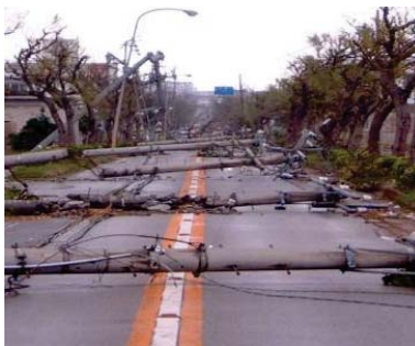
<電柱の倒壊による道路閉塞の事例> <歩行の支障となる電柱の事例>
