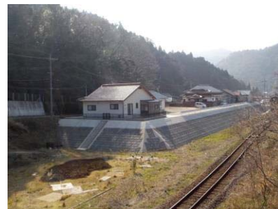
宅地嵩上げ整備箇所(松川橋付近)
