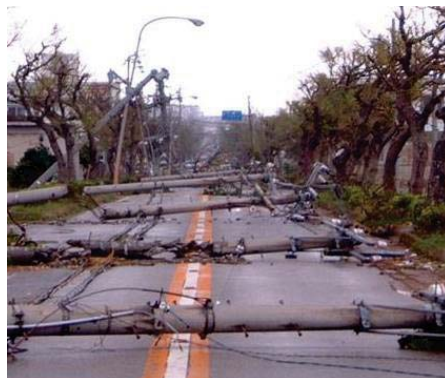
＜電柱の倒壊による道路閉塞の事例＞
