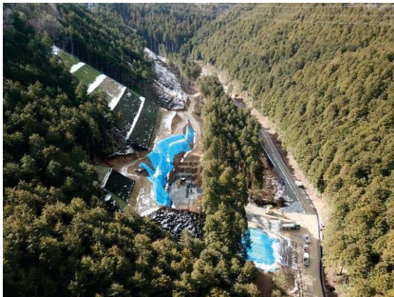
写真① 明木地区 工事状況 (H31.1月時点)
