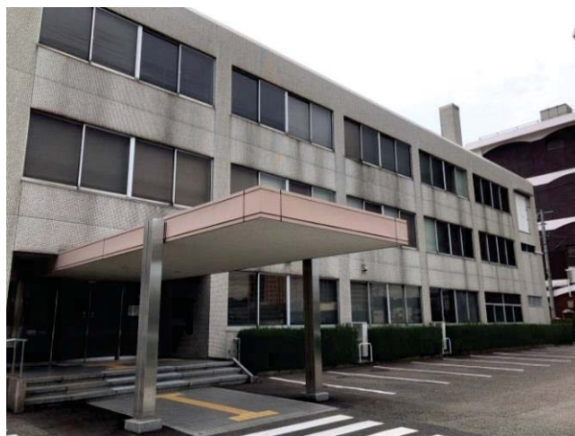
益田地方合同庁舎(現況)
