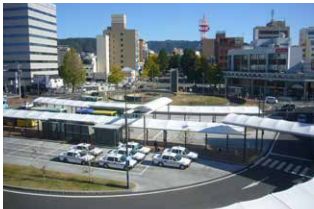
徳山駅前賑わい交流施設から北口駅前広場（写真下）、御幸通（写真中央）を望む
