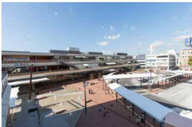
徳山駅前賑わい交流施設（写真中央）と前面に広がる北口駅前広場
