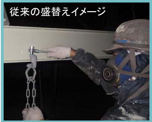
従来の盛替えイメージ 1本ずつチェーンを緩めてクランプを外し、クランプ移動後再度チェーンを締め付ける必要があった
