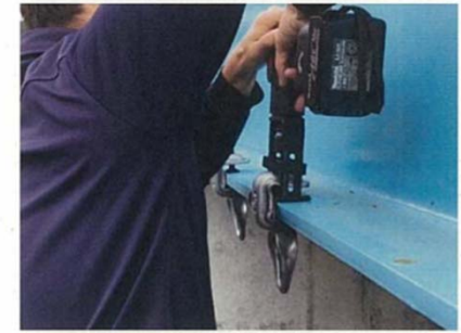
写真5 締め付け状況
