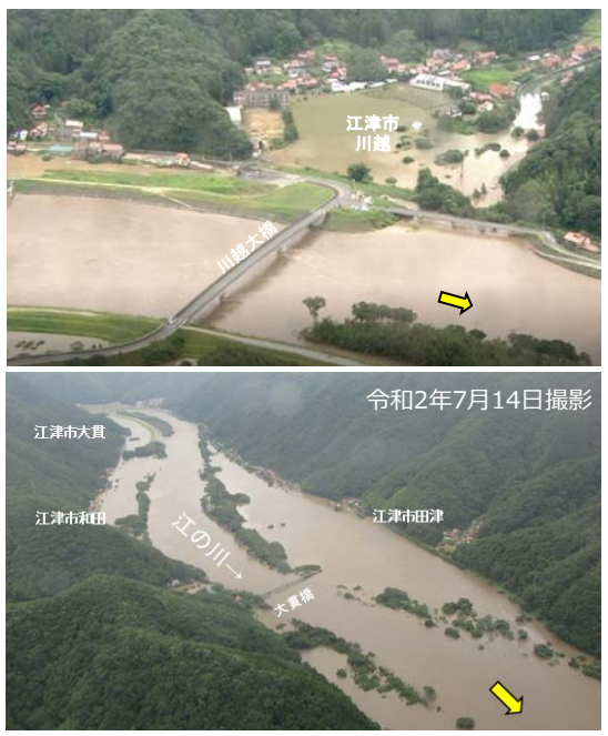
令和2年7月豪雨 江の川における浸水被害状況
