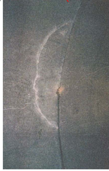
目地部に連結する半月状のひび割れ
