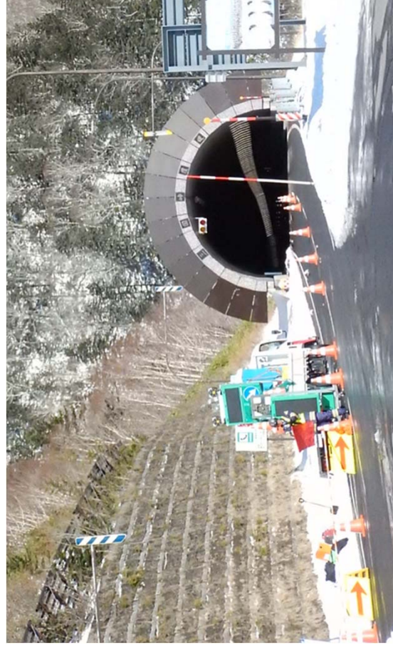
補修工事の実施状況(交通規制)
