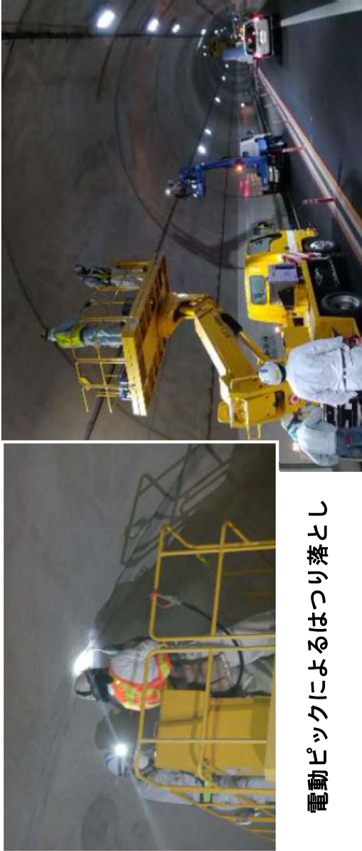
Co片のはく落発生による緊急の対策の実施状況
