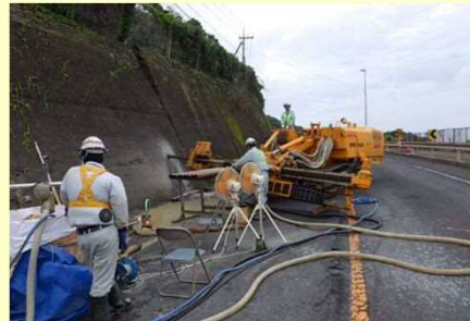
水抜きボーリング作業
