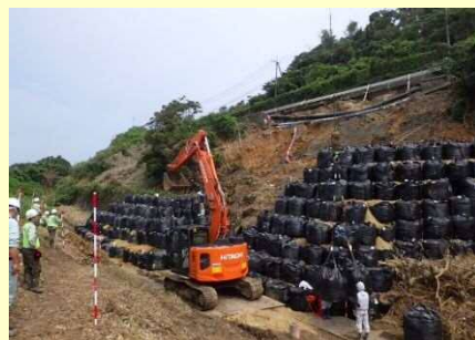
大型土のう設置作業
