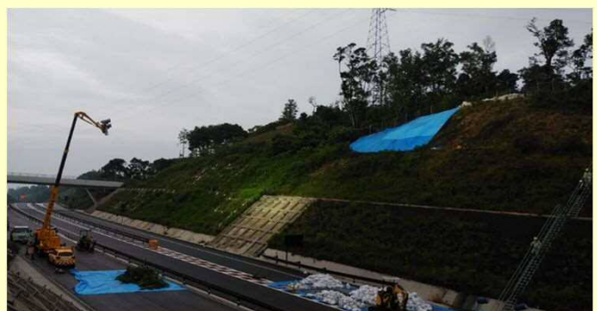
ブルーシート仮養生
