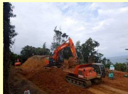
頭部排土掘削作業
