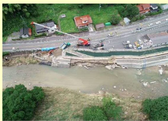
擁壁基礎先掘箇所の補修作業(R54) (島根県雲南市三刀屋町)
