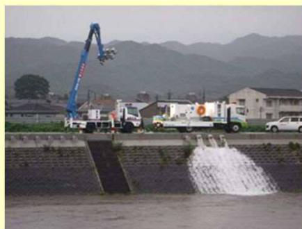
排水ポンプ車による排水作業 (鳥取県倉吉市)
