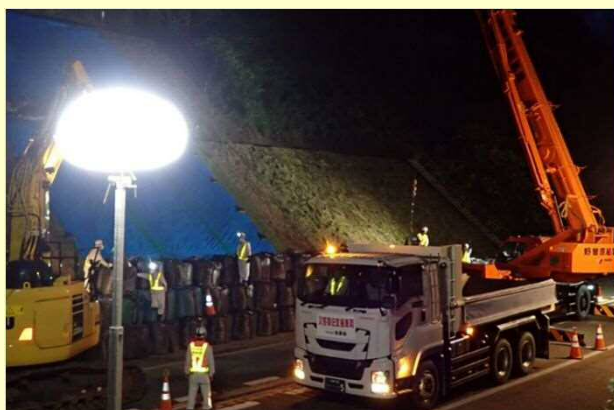
大型土のう設置作業 (松江自動車道)
