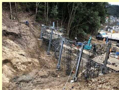
強靱ワイヤーネット設置作業
