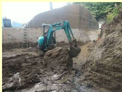
土砂撤去作業
