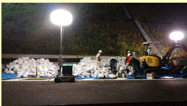
土のう作成作業
