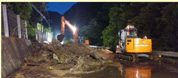
流出土砂の撤去作業 (R54) (島根県雲南市掛合町)
