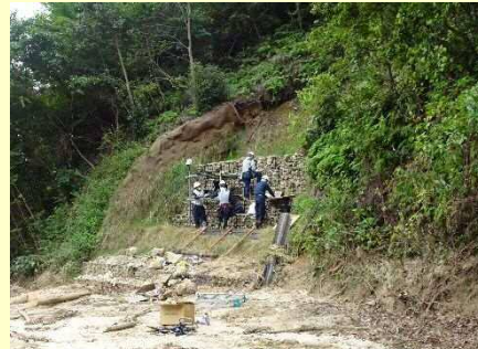
渓流監視カメラ設置作業
