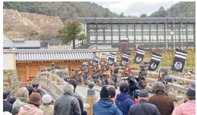
保存整備基本計画により復元した擬宝珠橋（大手橋）と中ノ御門表門（大手門）。中ノ御門表門（大手門） 竣工イベントに沸く様子。
