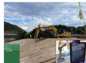
⑤安全衛生 (IoT技術の活用による グリーンホーダーへの風速の見える化)
