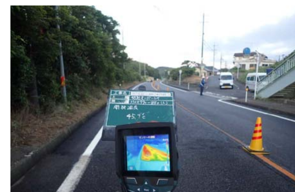
サーモグラフィーによる開放温度測定
