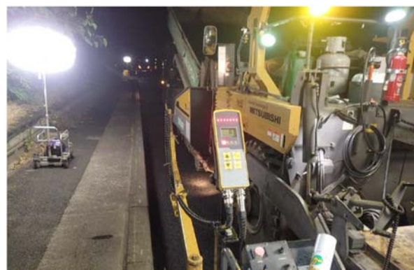
アスファルトフィニッシャー施工状況
