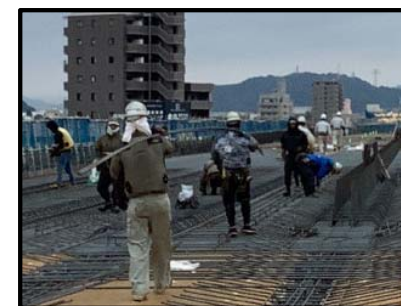
【人力による鉄筋搬入状況】
