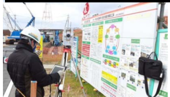
鋼矢板圧入精度計測モニター
