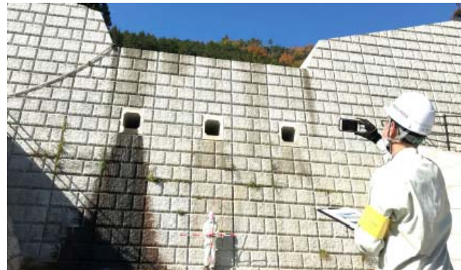
現地での点検データ取得
