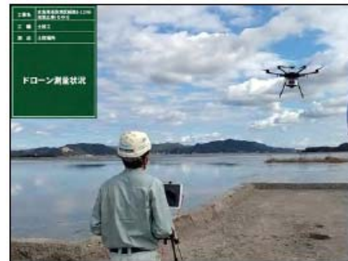
UAV(ドローン) 測量状況
