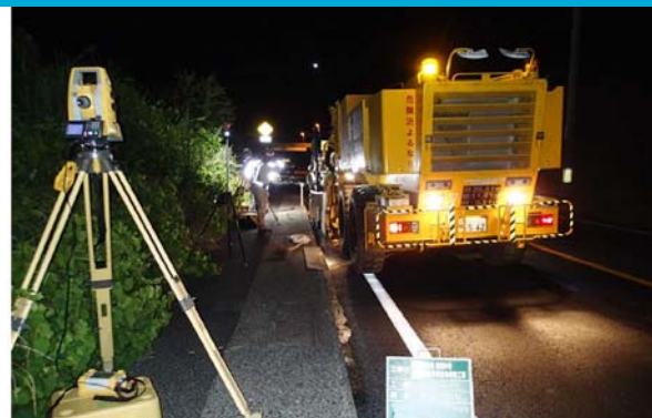
ICT活用による路面切削
