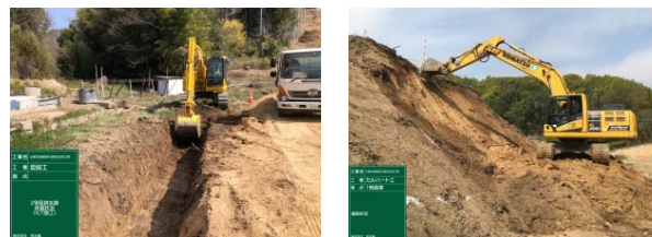
【ICT施工による作業土工施工状況】
