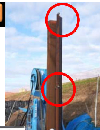
計測用ミラープリズム(上部・下部)
