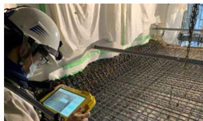
3眼カメラ配筋検査システム
