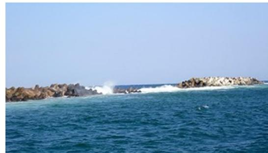
導流堤沈下状況 (R3.2撮影)
