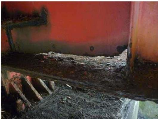
下フランジ及び垂直補剛材の腐食状況
