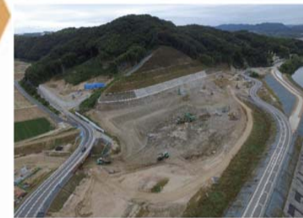
現場施工状況全景（2021年10月現在）
