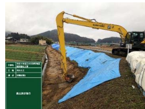
ロングアームバックホウ(MG)による作業の効率
