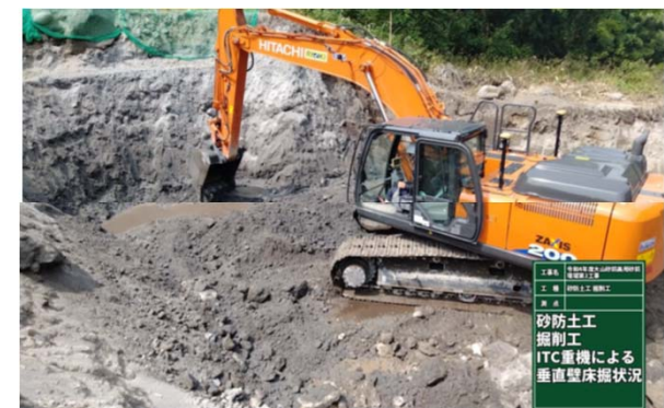
垂直壁床堀状況
