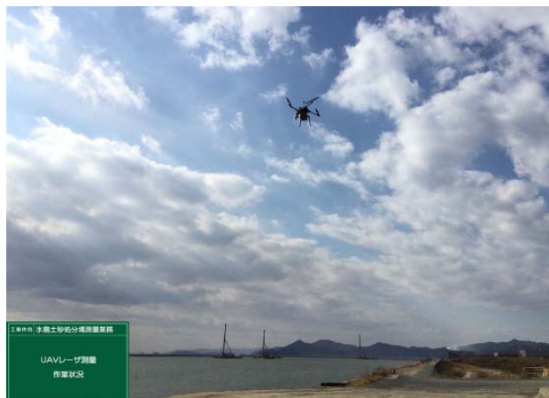
UAV測量(2) 実施状況 (岡山県倉敷市玉島乙島地先)
