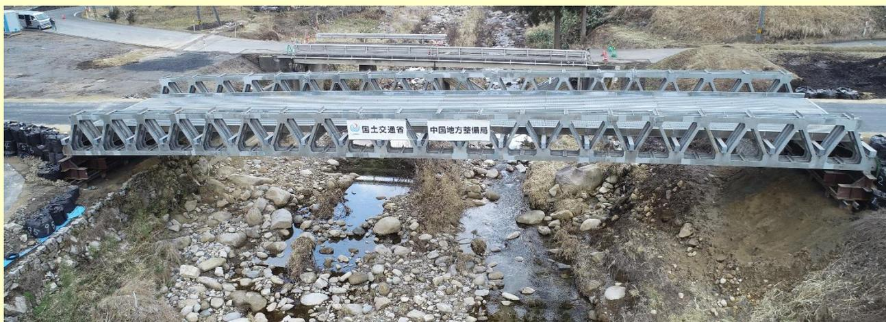
応急組立橋の架設作業完了（岡山県苫田郡鏡野町）
