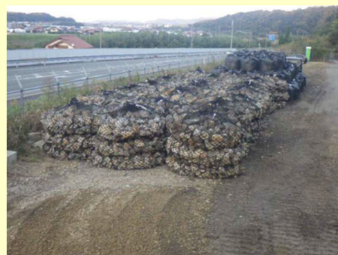
袋詰め玉石の製作 （島根県益田市）
