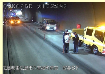
トンネル内緊急点検 (大山トンネル内)
