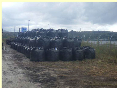
大型土のうの製作 （島根県益田市）
