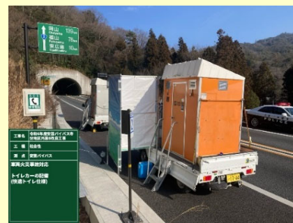
トイレカー配置 (広島県東広島市)
