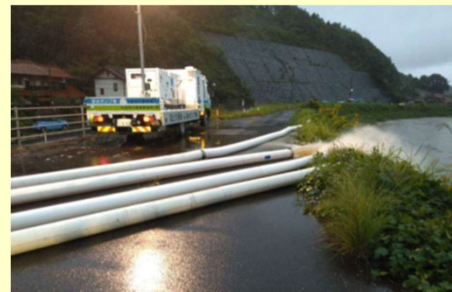
排水ポンプ車による内水排除 (島根県益田市)
