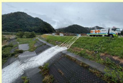
排水ポンプ車による内水排除 (島根県邑智郡川本町)
