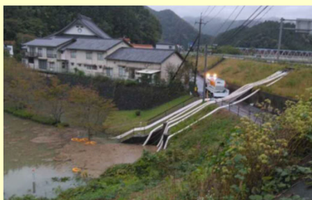
排水ポンプ車による内水排除 (島根県江津市)
