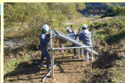
監視カメラの足場設置 (島根県鹿足郡吉賀町)
