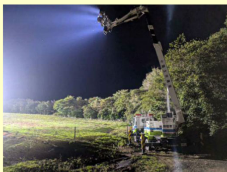
防疫作業支援 (浜田河川国道事務所)
