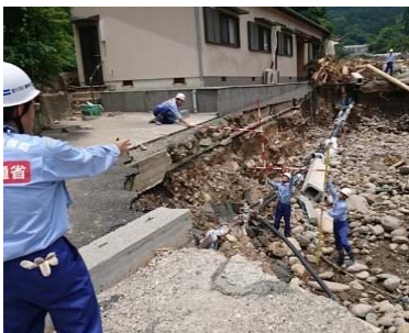
河川被害状況の調査
