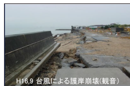
H16.9 台風による護岸崩壊(観音)
