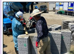
中詰コンクリート打設
