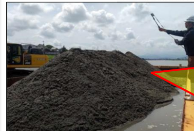
スマホによる浚渫土運搬量の計測
