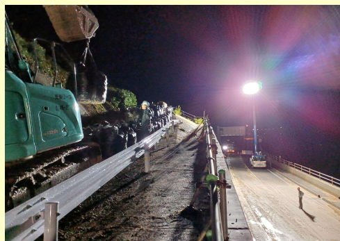
国道191号法面崩落現場で照明車による 夜間作業支援（山口県阿武郡阿武町）
