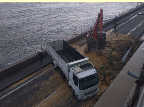
国道191号法面崩落現場で崩落土砂撤去、法面保護シート設置等、 （山口県阿武郡阿武町）
