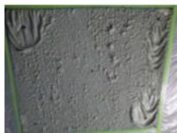
剥離剤塗布後
