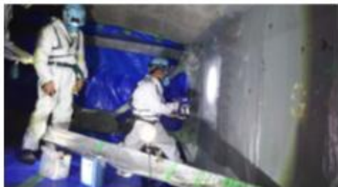
剥離剤塗布状況
