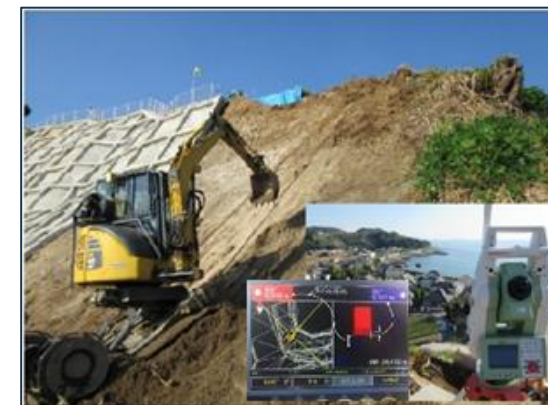
3D管理による特殊法面掘削工法
