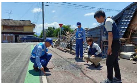
道路の被災状況調査(八代市)
