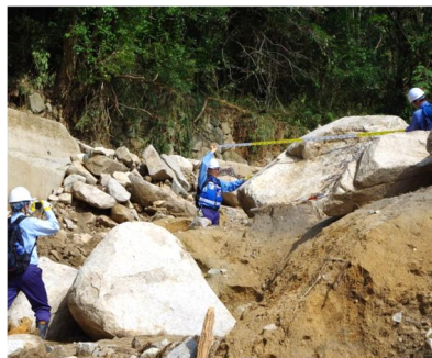
土砂災害被害状況の調査
