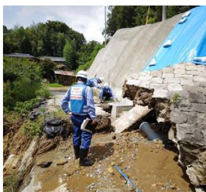
道路法面の被災状況調査 (千葉市)
