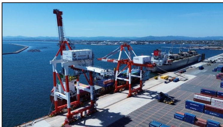
インバータ制御方式によるガントリークレーン（全2基）
