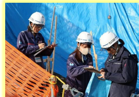
R1.12.2 現場安全衛生点検
