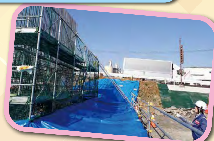
橋梁の配筋確認
