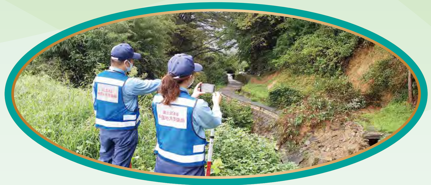
TEC-FORCE 被災状況調査（調査・記録）
