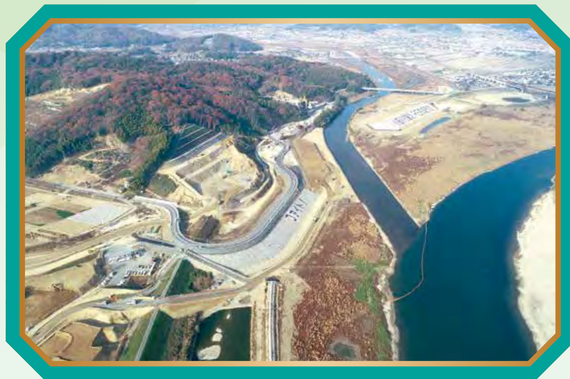
真備緊急治水対策プロジェクト（岡山県）
