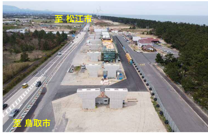
▲写真① 「道の駅」北条公園より松江市方面を望む
