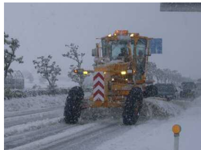
▲ 除雪グレーダーによる除雪作業
