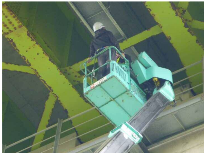
▲橋梁点検実施状況
