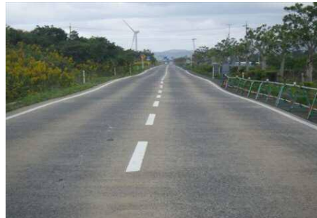
▲国道9号：地震による路面のうねり
