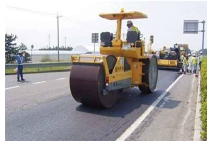
▲ 路面（アスファルト舗装）の補修
