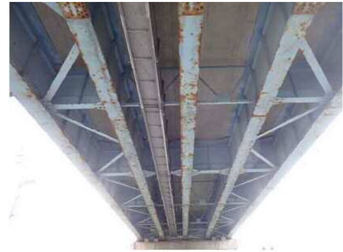
▲橋梁補修工事予定（日置川橋）
