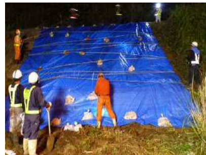
▲ 異常時（大雨等）の応急作業
