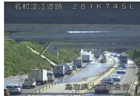
▲山陰道：豪雨による浸水
