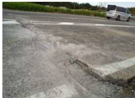
▲国道9号：地震による舗装の損傷
