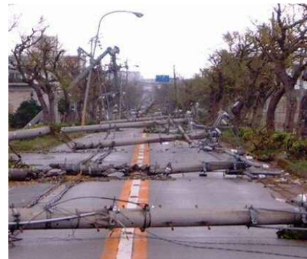
<電柱の倒壊による道路閉塞の事例>
