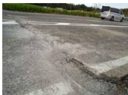
▲国道9号：地震による舗装の損傷
