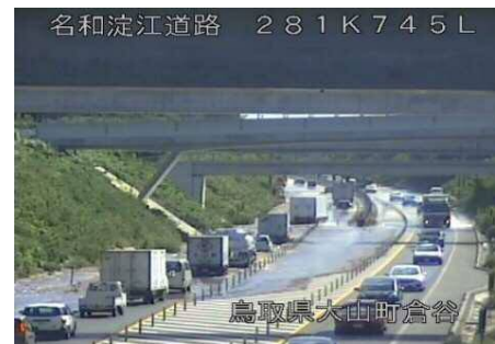
▲山陰道：豪雨による浸水
