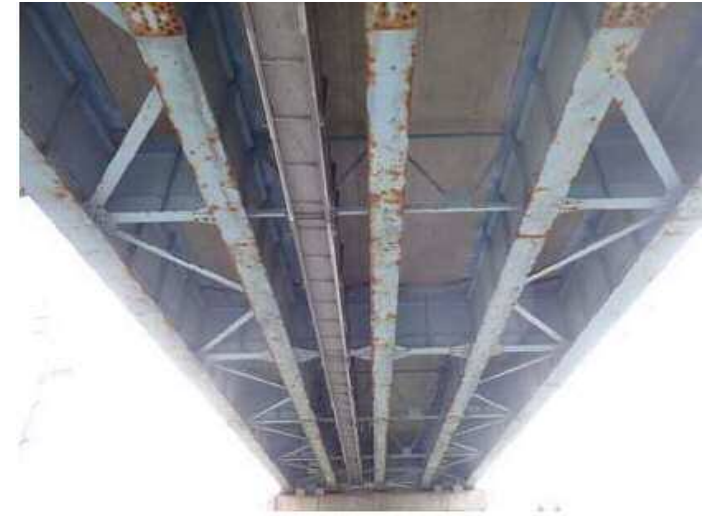
▲ 橋梁補修工事予定 (日置川橋)
