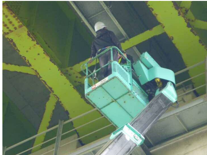
▲ 橋梁点検実施状況
