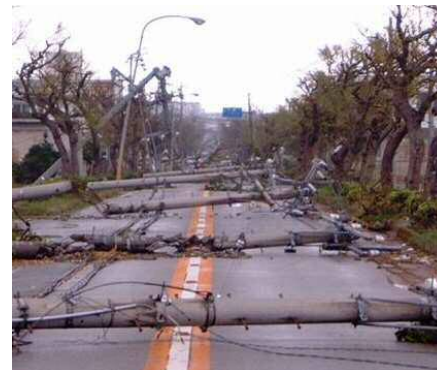
<電柱の倒壊による道路閉塞の事例>
