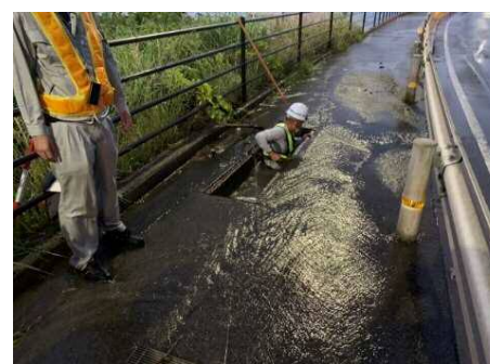
▲国道9号：水路閉塞による路面冠水
