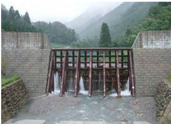
▲小泉2号砂防堰堤の土砂・流木補足状況 (2011(H23)年9月出水時)
