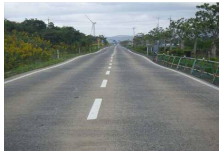
▲国道9号：地震による路面のうねり
