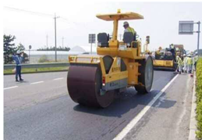
▲ 路面（アスファルト舗装）の補修
