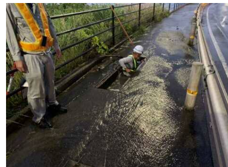
▲国道9号：水路閉塞による路面冠水
