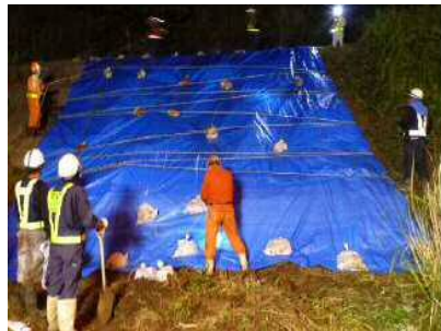
▲ 異常時（大雨等）の応急作業
