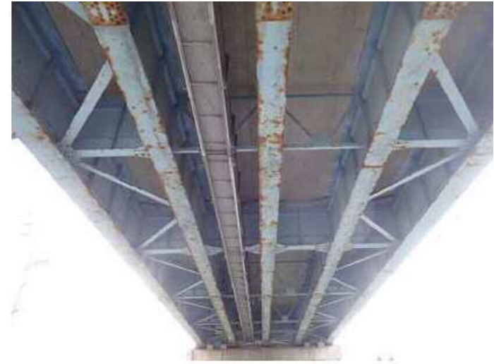
▲ 橋梁補修工事予定 (日置川橋)
