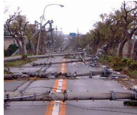
<電柱の倒壊による道路閉塞の事例>
