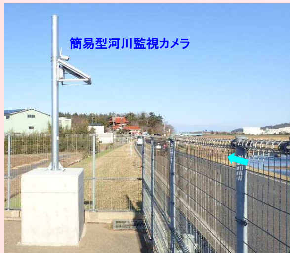
設置状況（天神川1k600左岸の場合）
