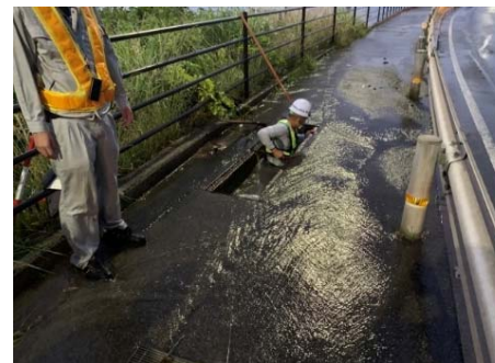
▲国道9号：水路閉塞による路面冠水
