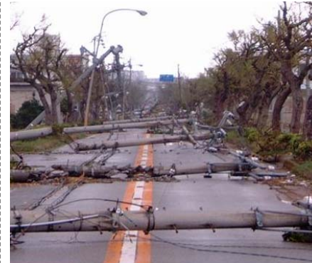
<電柱の倒壊による道路閉塞の事例>
