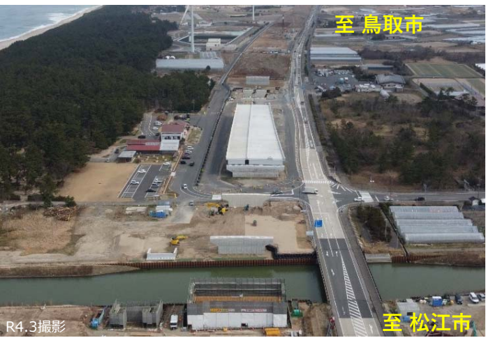
▲写真① 北条JCT (仮称) より鳥取市方面を望む
