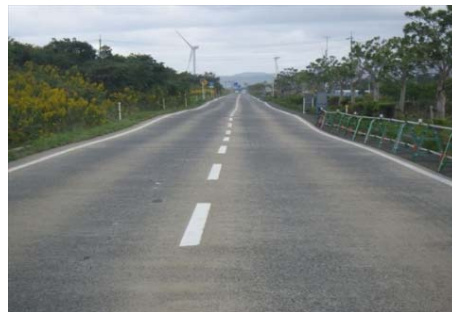
▲国道9号：地震による路面のうねり
