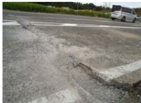
▲国道9号：地震による舗装の損傷
