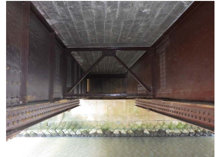
▲ 橋梁補修工事予定 (淀江新大橋)
