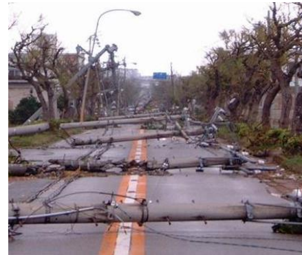
<電柱の倒壊による道路閉塞の事例>
