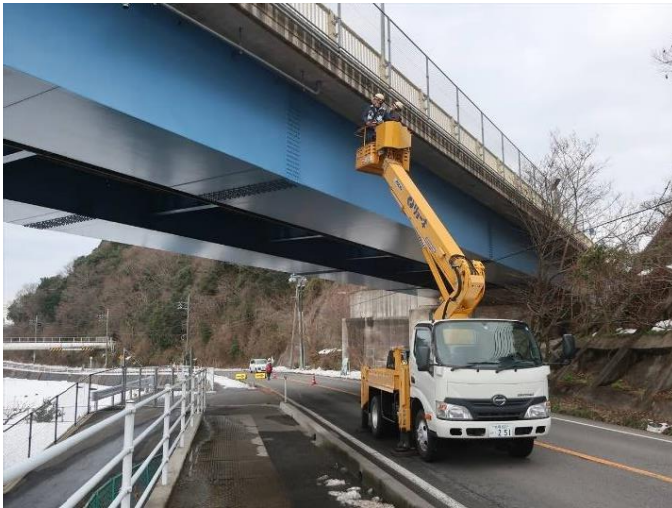
▲ 橋梁点検実施状況
