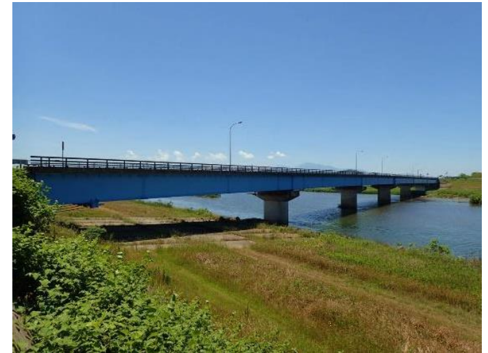
▲ 橋梁補修工事予定（新天神橋）
