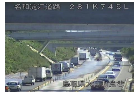
▲山陰道：豪雨による浸水
