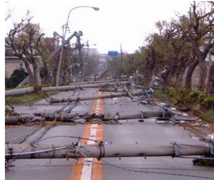
<電柱の倒壊による道路閉塞の事例>
