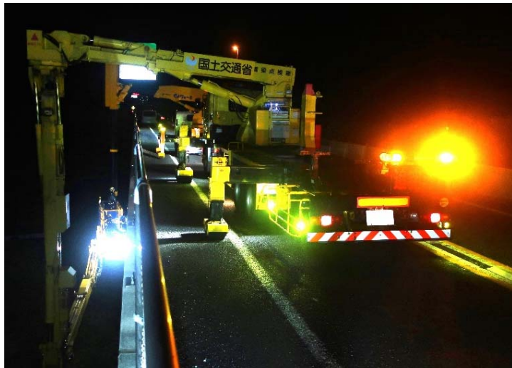
▲橋梁点検実施状況
