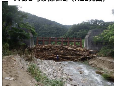
穴鴨3号砂防堰堤 (H25完成)
