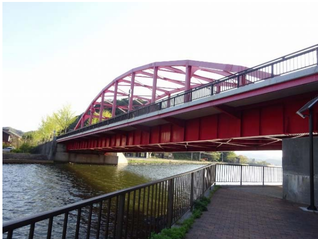
▲橋梁補修工事予定（深浦橋）
