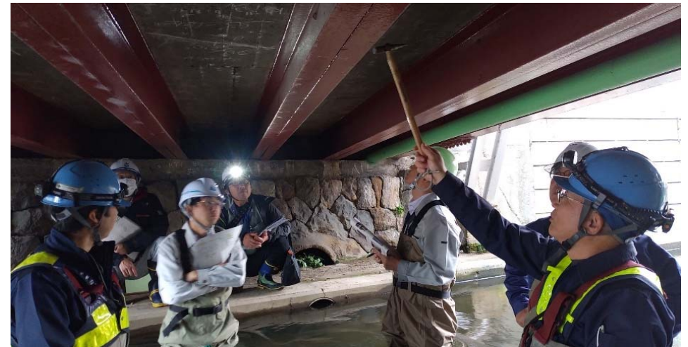
▲橋梁点検講習会（自治体支援）実施状況▲
