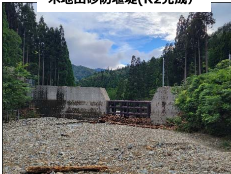
木地山砂防堰堤(R2完成)
