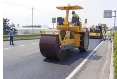
▲ 路面（アスファルト舗装）の補修
