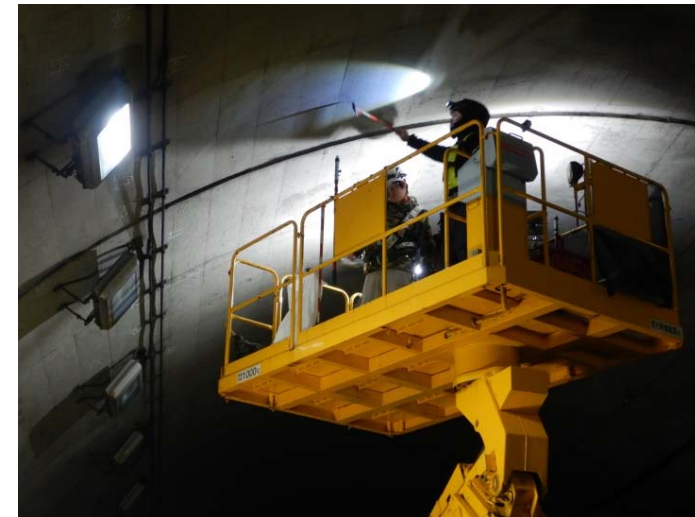
▲トンネル点検実施状況
