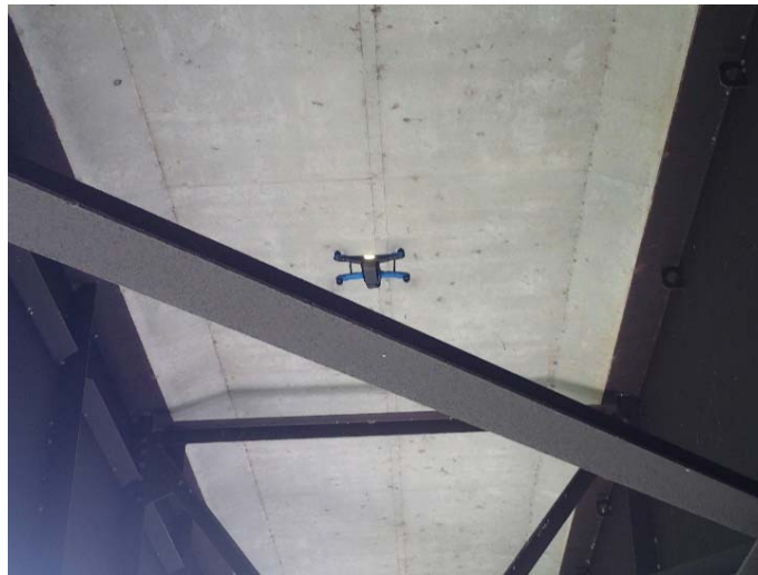
▲点検支援技術による橋梁点検状況（ドローン）
