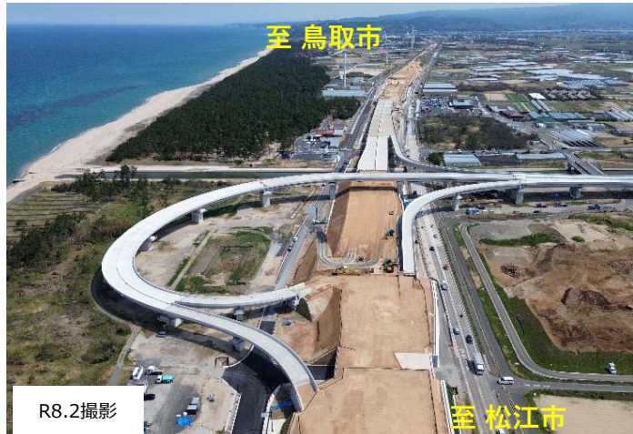
▲写真① 北条JCT (仮称) より鳥取市方面を望む
