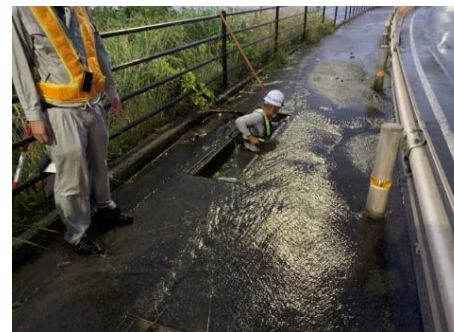
▲国道9号：水路閉塞による路面冠水
