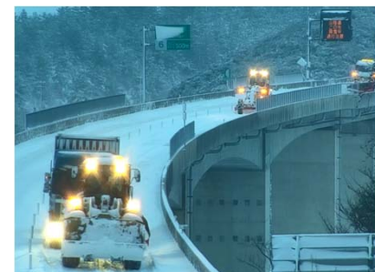
▲ 協力業者によるスタック車両牽引
