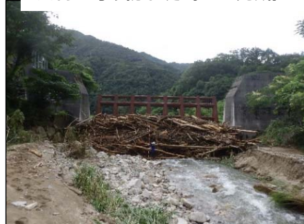
穴鴨3号砂防堰堤 (H25完成)
