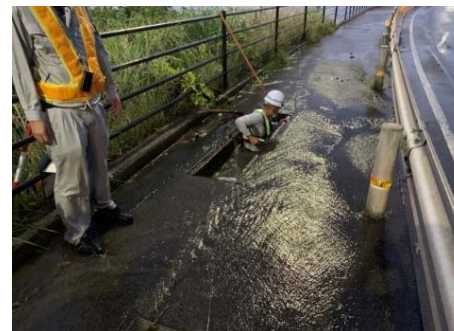
▲国道9号：水路閉塞による路面冠水
