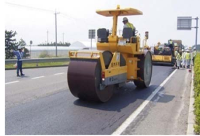
▲ 路面（アスファルト舗装）の補修
