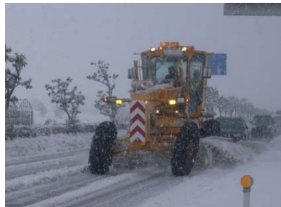
▲ 除雪グレーダーによる除雪作業
