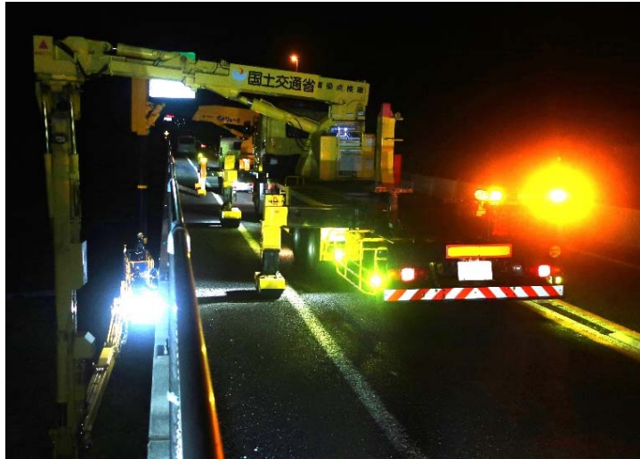
▲橋梁点検実施状況
