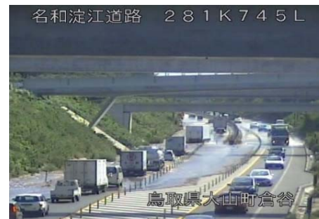
▲山陰道：豪雨による浸水
