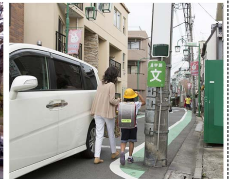
<歩行者の支障となる電柱の事例>
