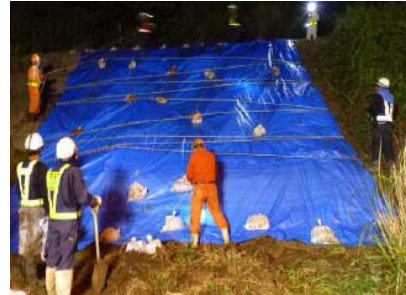
▲ 異常時（大雨等）の応急作業
