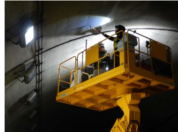
▲トンネル点検実施状況
