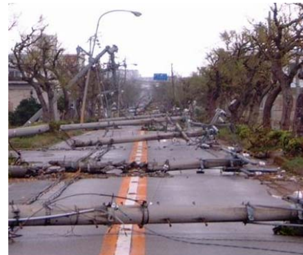
<電柱の倒壊による道路閉塞の事例>
