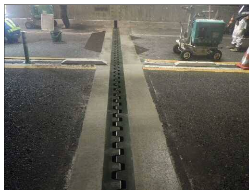
補修後(施工事例) 宇谷橋ジョイント(H30施工)
