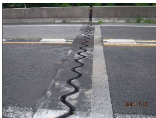
補修前 泊高架橋ジョイント(完成後17年経過)
