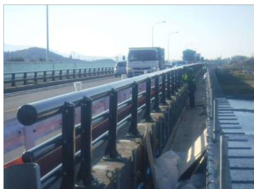
新天神橋 防護柵(更新後)
