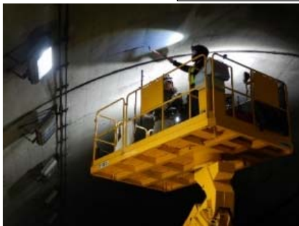
トンネル点検
