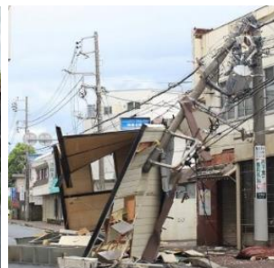
<飛来物による電柱倒壊の事例>
