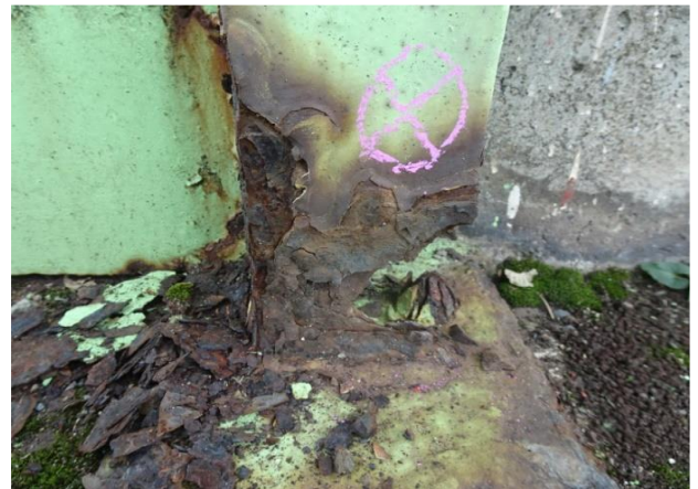
主桁の腐食
