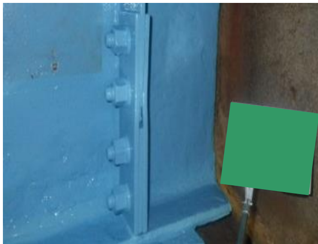
主桁鋼板の補修
