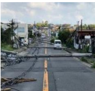
<電柱の倒壊による道路閉塞の事例>
