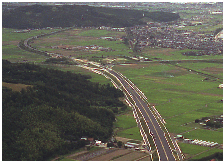
施工状況「淀江IC付近」 (大山町安原地内) 7月末現在
